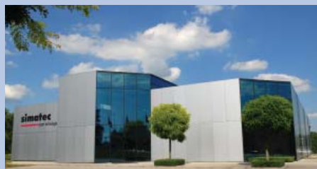
simatec ag, Wangen a. Aare, Switzerland
